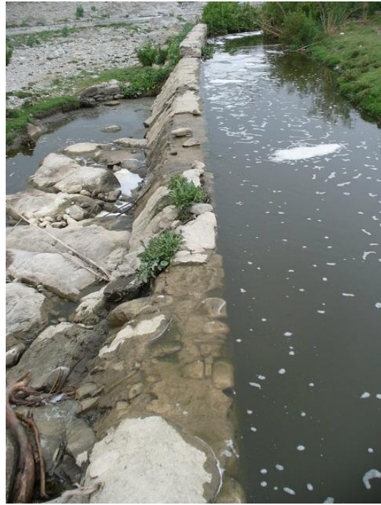
Fotos 4.12.- Canal de derivación al ejido Higo. Obsérvese fuga de agua al lado izquierdo del canal, la cual retorna al arroyo La Encantada.
