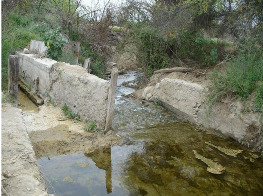
Foto 4.25.- Otro canal de riego aguas arriba del ejido Paredón, en el que se muestra la forma en que se separa el agua para los ejidatarios de Paredón (a la izquierda) y a San Francisco Paredón (a la derecha).
