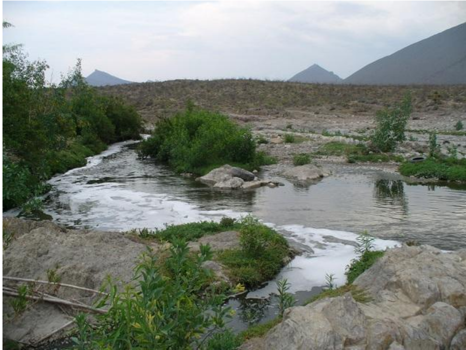
Foto 4.11a.- Salida del canal de derivación al ejido Higo, en el arroyo La Encantada a la altura del ejido Zertuche.
