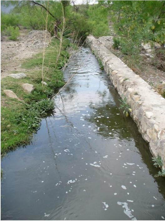
Fotos 4.12.- Canal de derivación al ejido Higo. Obsérvese fuga de agua al lado izquierdo del canal, la cual retorna al arroyo La Encantada.
