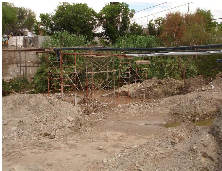
Foto 2.4.- Arroyo La Encantada a la altura del centro de Ramos Arizpe, en época de lluvias.
