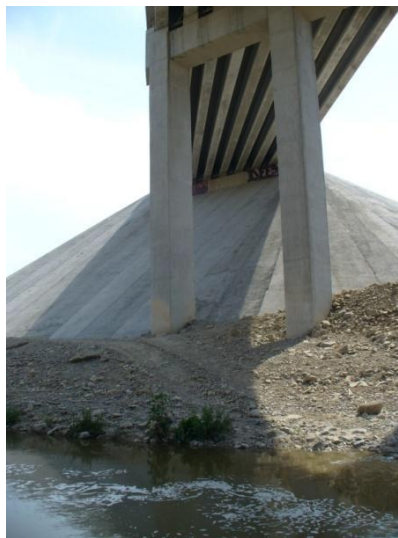
Foto 5.4.- Arroyo La Encantada, bajo puente en la autopista Monterrey-Saltillo, después de la planta tratadora de Ramos Arizpe
